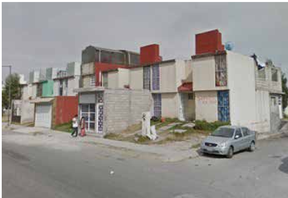
Figura 2: Dimensiones de 70 m 2 a menor superficie sobreponiendo criterios económicos a la calidad de vida en Fraccionamiento Colinas del Sol.
