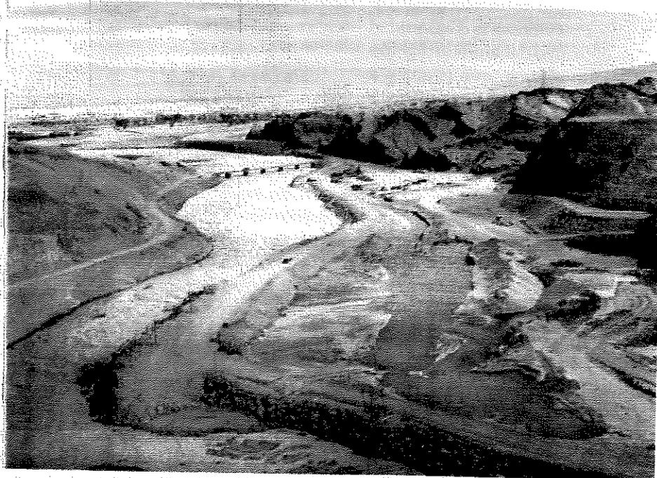
Foto 1.- El río ya ha sido desviado con la construcción de una ataguía para permitir la realización de las obras.- Fotografía tomada en el primer trimestre de 1972.-
