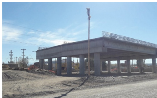
Figura 6: Puente ensamblado en calle Oro
