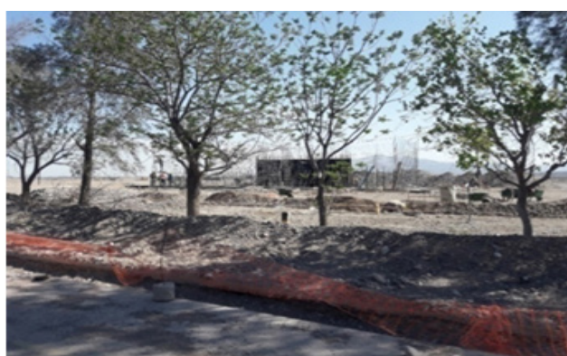
Figura 38: Obras en el predio ferial (edificios y agua potable)
