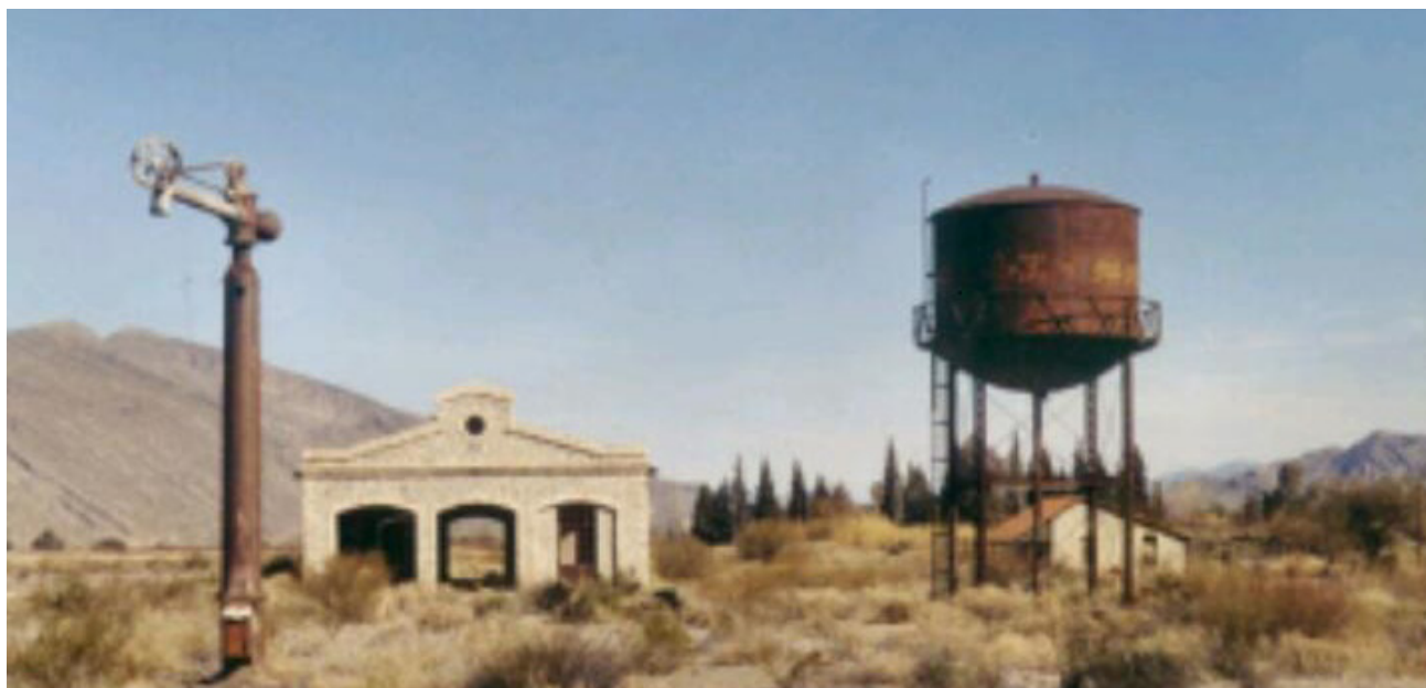
Figura 3: Depósito, tanque de agua y vivienda ferroviaria.
