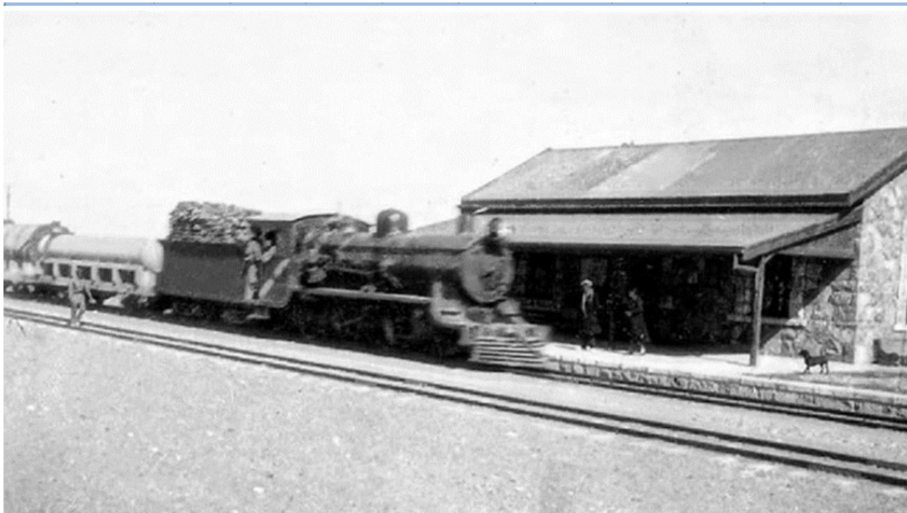
Figura 2: Estación de Niquivil, perteneciente al ramal que concluía en San José de Jáchal.
