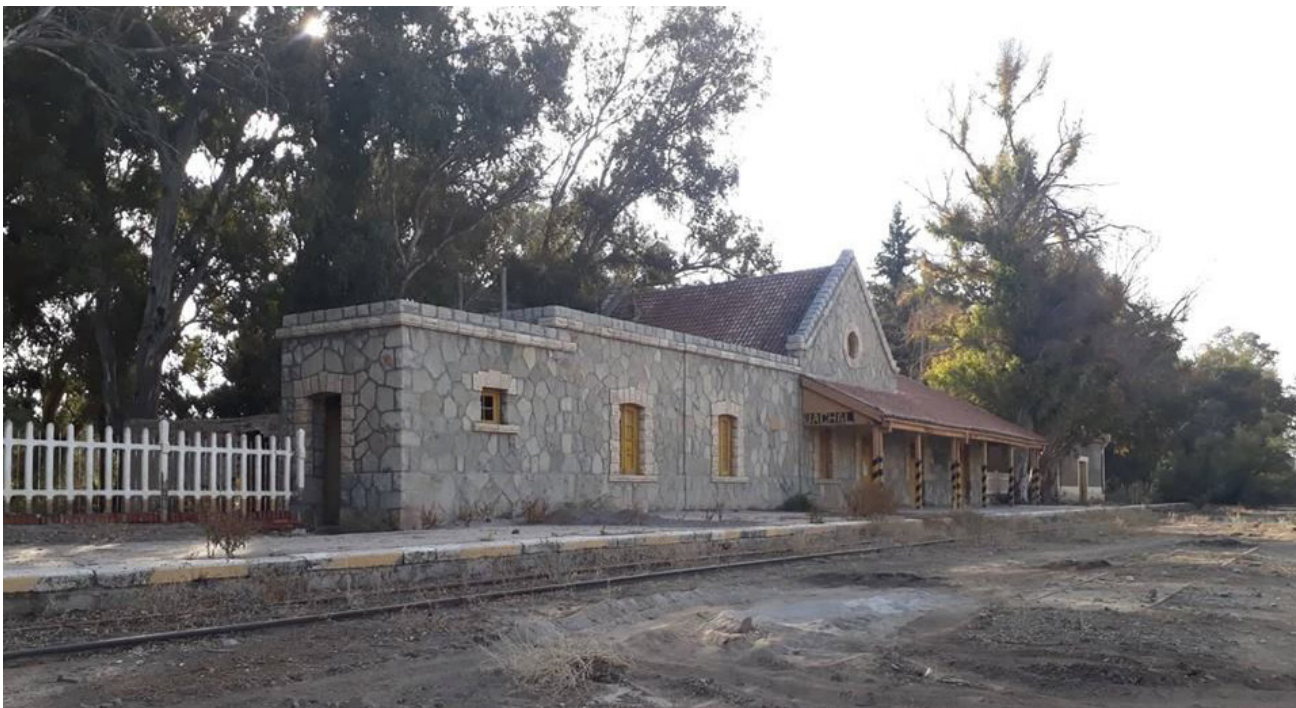
Figura 4: Edificio central de la estación San José de Jáchal.
