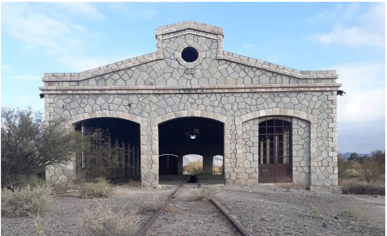
Figura 5: Depósito de locomotoras(en el edificio, no sólo se guardaban las mismas, sino que también, se reparaban las locomotoras en caso de que tuviesen algún desperfecto).En la foto se pueden observar restos de las vías de tren.
