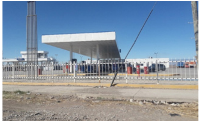
Figura 32: Estación de servicios en Centenario y RN 40
