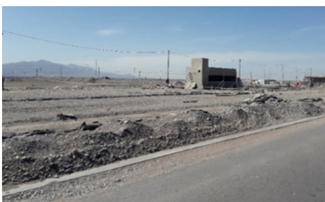
Figura 37: Nivelación y primeras construcciones
