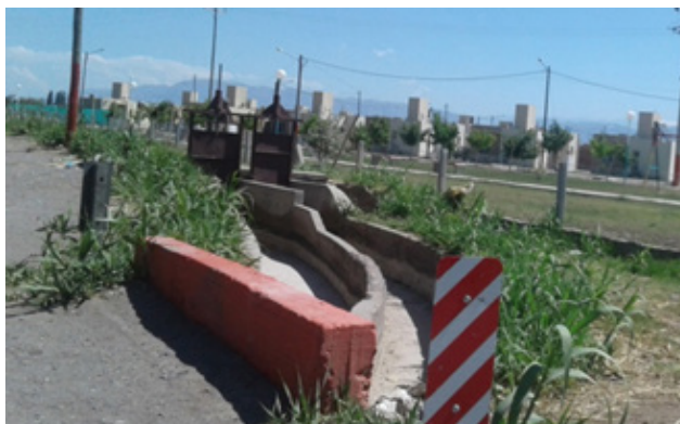
Figura 24: Comparto en canal de tierra calle Rodríguez
